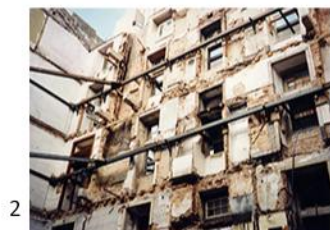
1 - Completa adulteração da estrutura antiga, com grande aumento de cargas verticais.
