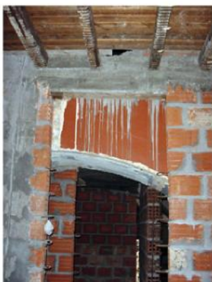
1 - Completa adulteração da estrutura antiga, com grande aumento de cargas verticais.
