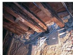
1 - Completa adulteração da estrutura antiga, com grande aumento de cargas verticais.
