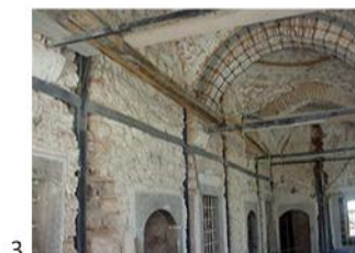
1 - Completa adulteração da estrutura antiga, com grande aumento de cargas verticais.
