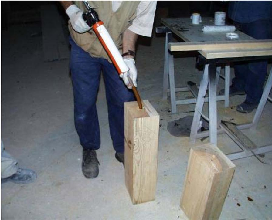
*Prova prática de qualificação de um carpinteiro com treino específico para aplicação de produtos poliméricos e FRP.*
