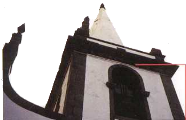
Igreja de Castelo Branco (Faial) - Elemento de atiramento aplicado após o sismo da década de 20
