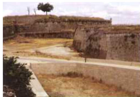
O atravessamento do fosso executado da forma que a imagem documenta corta a leitura do sistema defensivo. A guarda em pedra confunde ainda mais o observador
