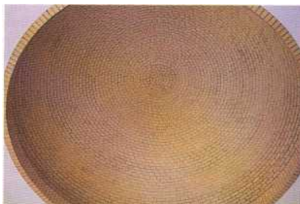
Cúpula da residência de estudantes de Serpa (tijolo à vista)
