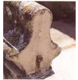
Apeamento dos elementos em cantaria deslocados ou fracturados
