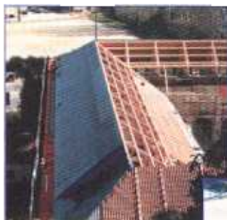
Convento de S. Francisco Coimbra Reabilitação e beneficiação das coberturas Execução de cobertura dupla com isolamento
