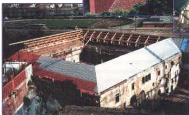
Convento de S. Francisco Coimbra Reabilitação e beneficiação das coberturas Execução de cobertura dupla com isolamento
