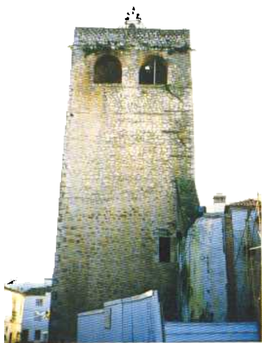
Vista da Torre do Relógio antes da intervenção (fachada nascente).
