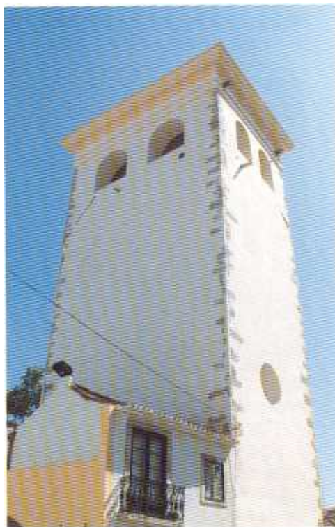
Aspecto final da Torre do Relógio após a intervenção (fachadas poente e sul).
