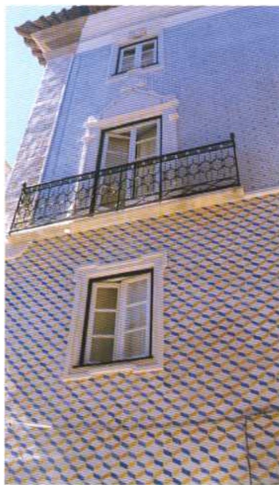
Évora, imóvel na Rua 5 de Outubro, depois do restauro.
