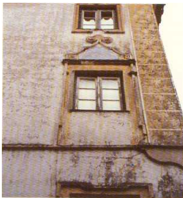
Évora, imóvel na Rua 5 de Outubro, antes do restauro.
