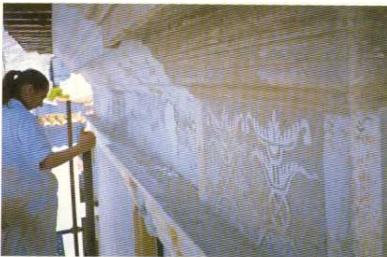
Imóvel na Rua 5 de Outubro, em Évora: a re-auradora responsável, Ana Sofia Lopes, a remover camadas de pintura.
