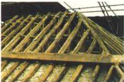
Sala das Batalhas, fasquiado de suporte dos tectos de gesso.
