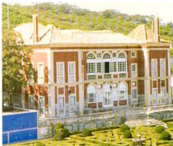
Aspecto geral da fachada fronteira ao Jardim Grande.
