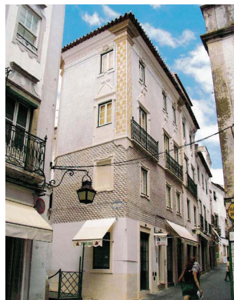
Évora, 5 de Outubro, edifício após o restauro.
