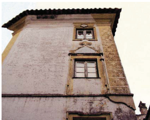
Évora, edifício na Rua 5 de Outubro, antes do restauro.
