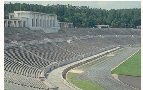
Estádio Nacional, onde foi utilizada a Cal Hidráulica de Martingança
