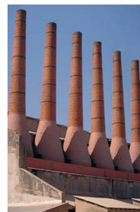
Chaminés de Fornos de Cal Hidráulica, Secil Martingança
