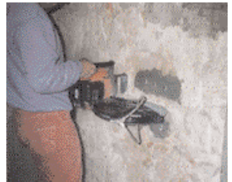
Corte da alvenaria para realização do ensaio de "macaco de plano"
