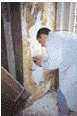
Medição da humidade nas paredes
