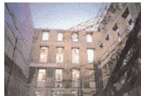
Fig. 4 - Demolição total do interior com manutenção apenas de fachadas
