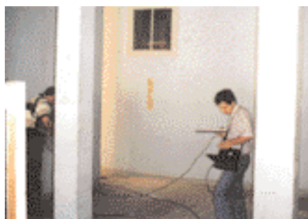
Fig. 3 - Introdução de elementos de betão armado
