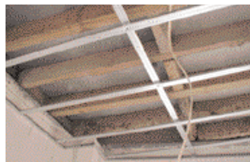
Preparação dos vigamentos de madeira para aplicação do forro de tecto. Superiormente, placas duplas de Viroc garantem a protecção contra o fogo e a base para aplicação do acabamento final
