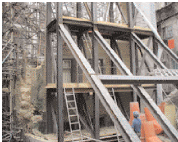
Escoramento provisório da fachada posterior, a desmontar por se encontrar arruinada
