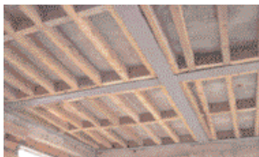
Vista geral de pavimentos de madeira com vigas de aço centrais; em todo o perímetro regista-se a cinta de aço que garante o apoio do pavimento e o travamento das paredes. Sobre os vigamentos são visíveis as placas de Viroc que constituem o revestimento do piso
