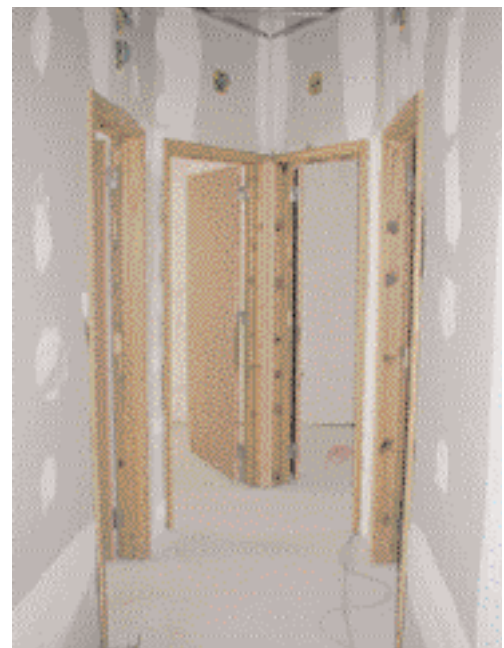
Novas divisórias com estrutura de madeira forrada com placas duplas de gesso cartonado
