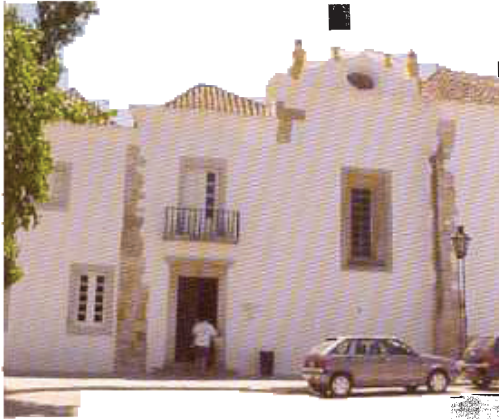
Entrada do Convento de Faro.
