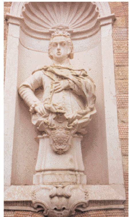
Fig. b - Estátua de D. João VI, após intervenção.
