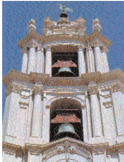
Torre da Igreja do Convento, depois dos trabalhos de limpeza das cantarias
