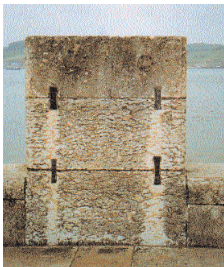
Fig. 2 - Torre de Belém. Baluarte, lado sul. Calcário apinhado - pormenor.
