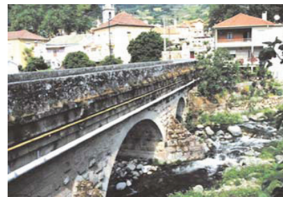
Ponte de Mação. Vista do paramento de montante.
