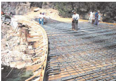
Ponte de Mação. Montagem de armaduras na laje do tabuleiro.
