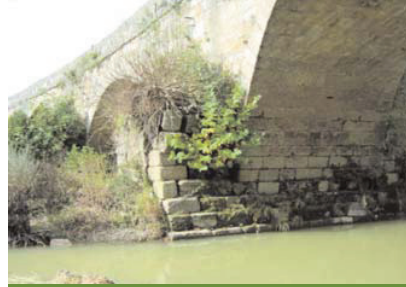
Ponte de Pedrinhas. Talha-mar de jusante e nascente de uma abóbada.
