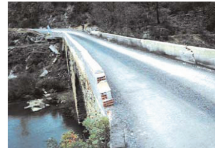
Ponte de Mação. Largura existente da faixa de rodagem.
