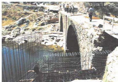
Ponte de Mação. Trabalhos de alargamento de um encontro.
