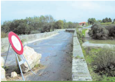
Ponte de Pedrinhas. Pavimento revestido da ponte nascente e muros de guarda.
