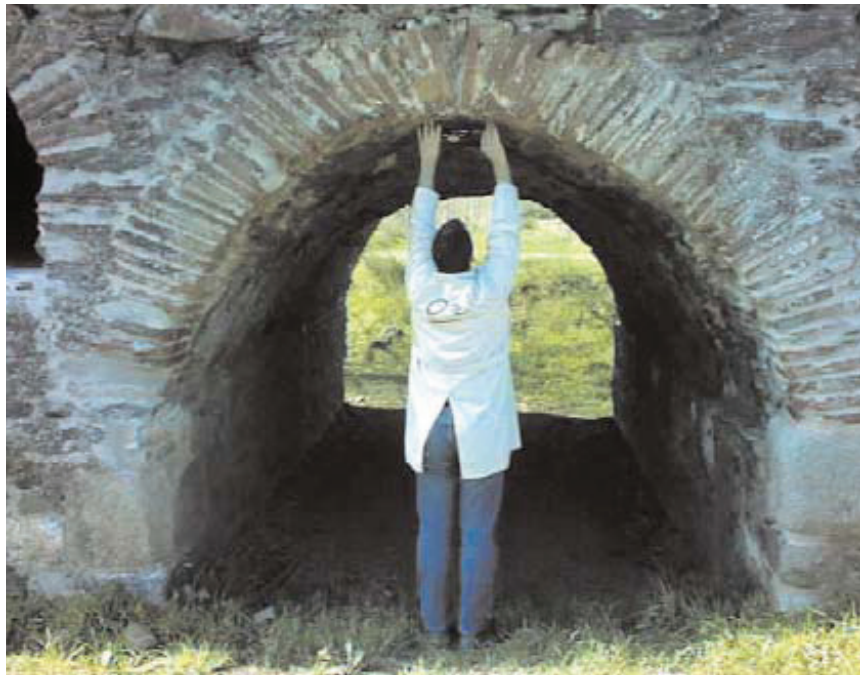
Ponte de Vila Ruiva. Medição da abertura de uma fissura com alongâmetro.
