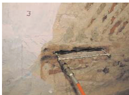
Macaco plano semicircular introduzido num entalhe previamente executado numa abobada.
