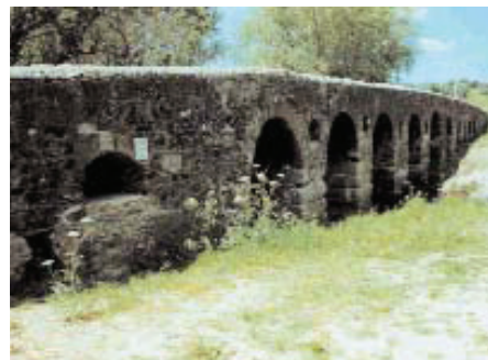
Ponte de Vila Ruiva. Vista de montante.
