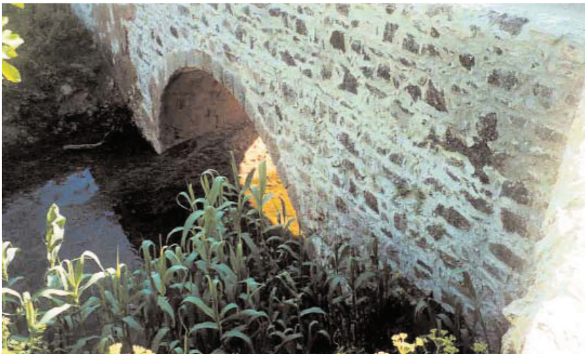
Ponte de Brenhas. Paramento de jusante.
