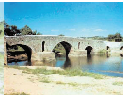
Ponte de Monforte. Paramento de jusante.
