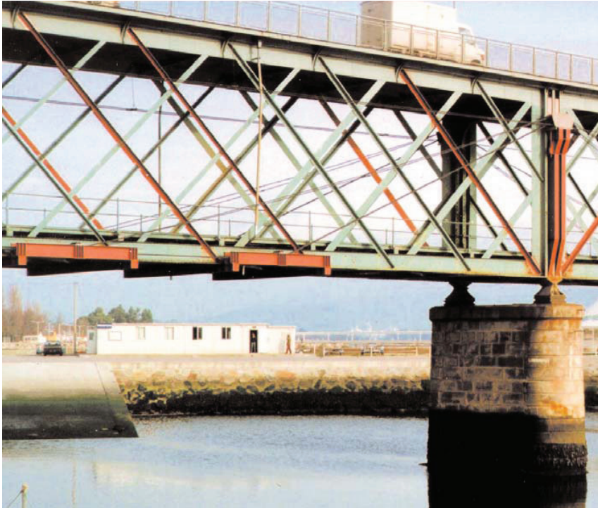
Figura 2 - Barras pré-esforçadas e desviadores.
