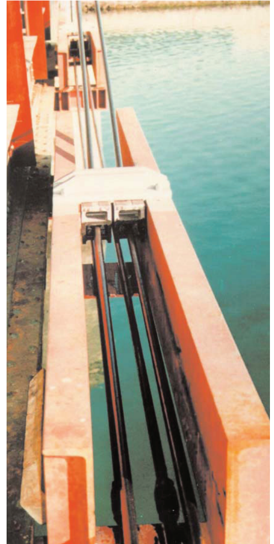
Figura 3 - Barras pré-esforçadas e desviadores - pormenor.
