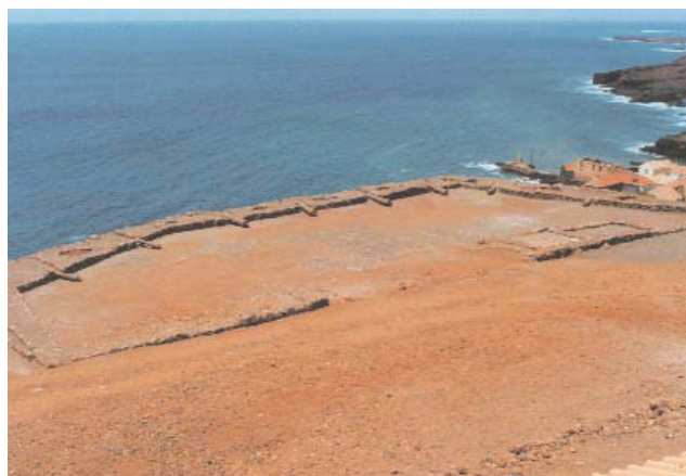
Figura 5: Vista geral da estrutura militar após a conclusão dos trabalhos.
