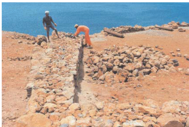
Figura 4: Trabalhos de preenchimento e de consolidação das paredes do forte.
