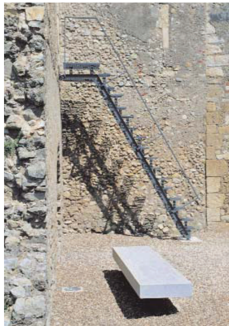
Em baixo: Escada exterior.
