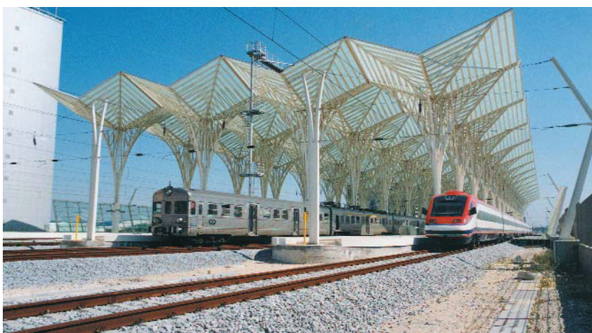
Vistoso ex-libris do interface de Lisboa-Oriente, eis a cobertura desenhada pelo arquitecto espanhol Santiago Calatrava. Pena é que realmente não proteja das intempéries e que a estação não tenha espaços de acolhimento e de espera...
