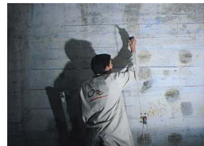
Figura 4 - Medição da resistividade eléctrica do betão noutra zona de ensaios.
