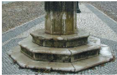
Pormenor antes da intervenção.
