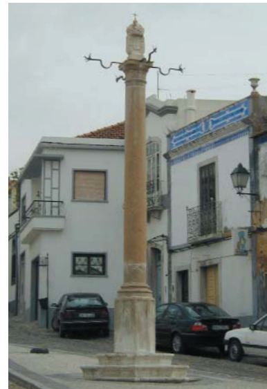
Aspecto final após a intervenção.
