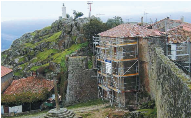
Figura 1: Recuperação do núcleo histórico de Penamacor. Zona sob intervenção.
