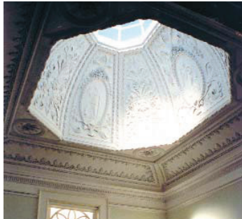
Palacete Barão da Trovisqueira Lanternim – concluído.
