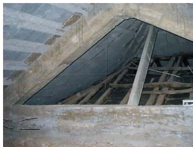
Figura 2: Nova estrutura de cobertura em betão armado (trabalhos efectuados nos anos 70 e 80).
