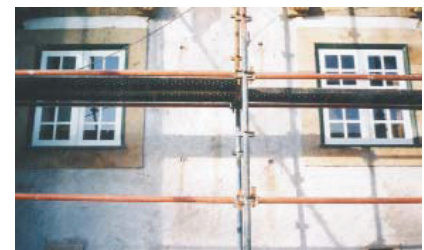
Figura 5: Furação nos nembos para colocação de conectores de solidarização dos dois panos das paredes.
