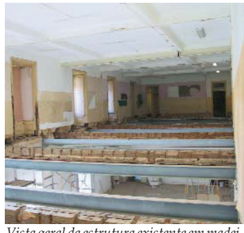
Vista geral da estrutura existente em madeira e nova metálica.
