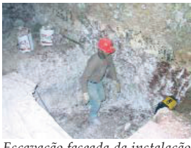
Escavação faseada da instalação sanitária.
