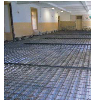
Vista da cofragem colaborante com armaduras e tubagens eléctricas.
