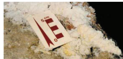
Foto 2: Desenvolvimento de eflorescências salinas na borda NW da piscina do Banho da Rainha.
