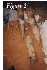
Figura 2: Estacas acabadas de arrancar. São bastante curtas, e não sendo, propriamente, estacas de fundação. Serviram, apenas, para criar, no terreno submerso, uma camada mais ou menos compacta e confinada, capaz de suportar as alvenarias. Exceptuando as cabeças, as estacas estão em bom estado, porque estavam imersas, na maior parte do seu comprimento.
