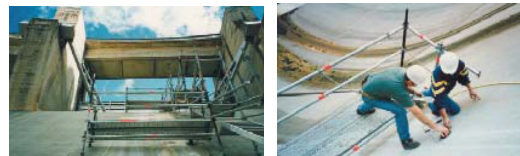
Figuras 1 e 2: Vista parcial do descarregador de superfície com as plataformas de acesso às zonas de ensaios e detecção de armaduras e medição do recobrimento com o pacómetro.
