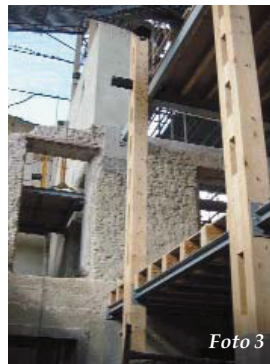
Foto 1: Apoios de vigamento em madeira sobre treliça metálica. Foto 2: Construção de parede com nova estrutura em cruz de St.º André. Foto 3: Pilares de madeira com 11 m de altura em pinho AA (casquinha). Foto 4: Pormenor da estrutura em cruz de St.º André.
