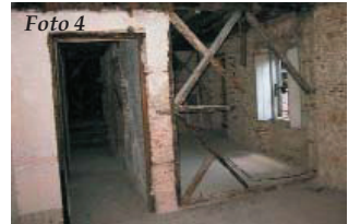
Foto 1: Apoios de vigamento em madeira sobre treliça metálica. Foto 2: Construção de parede com nova estrutura em cruz de St.º André. Foto 3: Pilares de madeira com 11 m de altura em pinho AA (casquinha). Foto 4: Pormenor da estrutura em cruz de St.º André.
