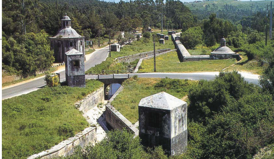
Foto 1: Aqueduto das Águas Livres. Nascente de Carenque.
