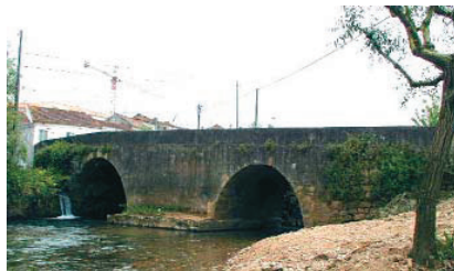
Vista geral da ponte do lado jusante.
