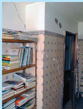
Foto 5: Fendilhação. Assentamento das fundações.
