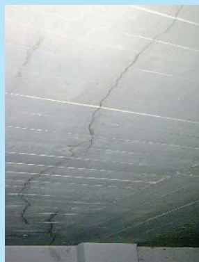
Foto 4: Fendilhação. Má concepção face às principais acções.
