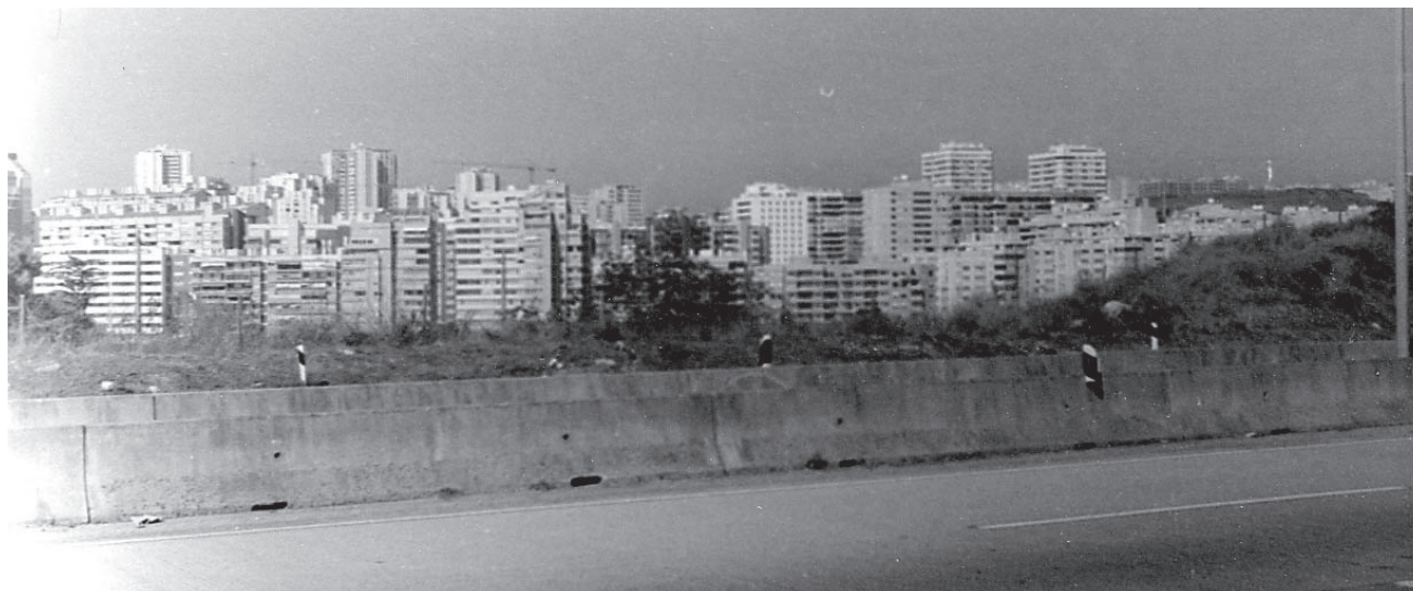
Foto 1: A massa gigantesca de construção (...)
