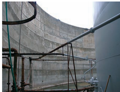
Vista interior da bacia de retenção
