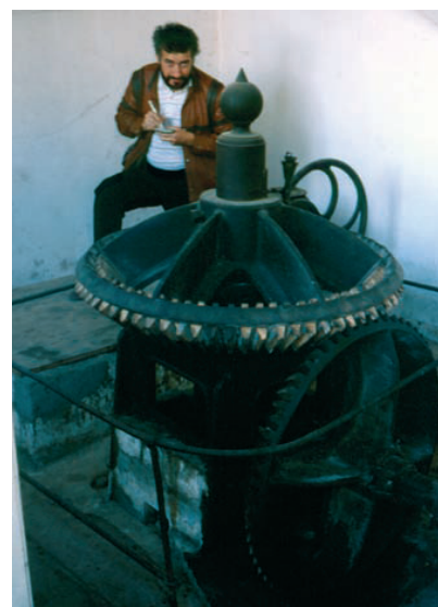
Caldeira Babcock & Wilcox da Fábrica Nacional de Munições
