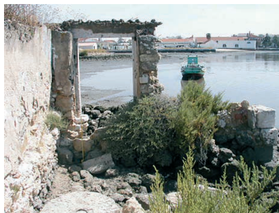
Vista interior do moinho antes do início dos trabalhos (Agosto de 2003)
