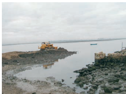
Fase de construção da enscadeira
