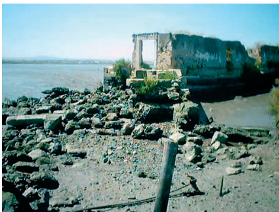
Moinho de maré do Cais das Faluas. Aspecto geral do estado de conservação do moinho antes da intervenção (Agosto de 2003)
