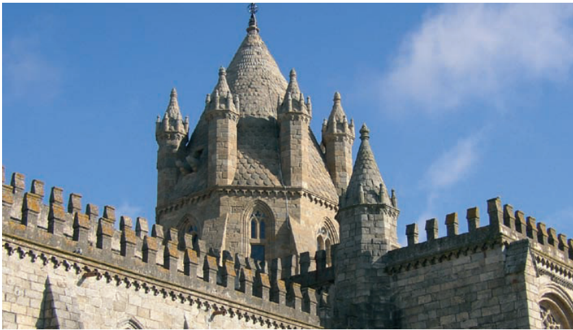
Zimório da Sé depois das obras
