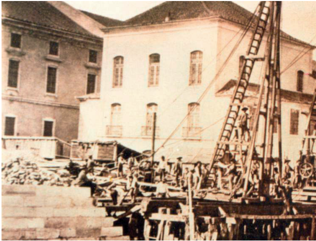
Obras no cais da Alfândega, 1877
