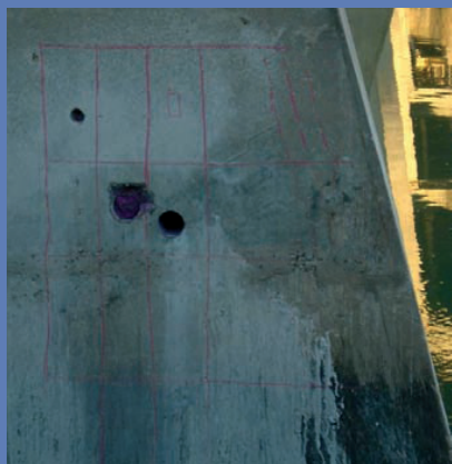
Zona de ensaios com as malhas de armaduras levantadas com o pacómetro (medição do recobrimento)
