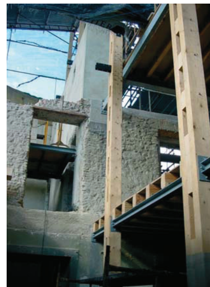
Escola 88: pilares de madeira
