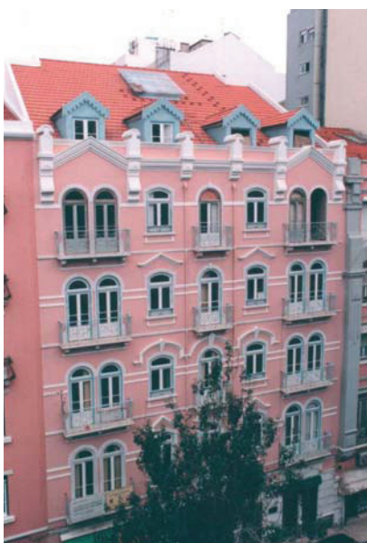
Av. Visconde Valmor, n.º 28: fachada do edifício já reparada
