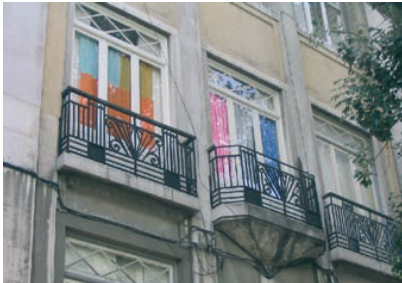
6 - Prédio de rendimento art déco da R. Tomás Ribeiro, n.º 93
