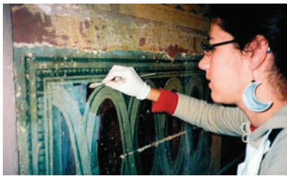
Sala de jantar - sondagens e remoção de camadas sobrepostas por processo químico, neutralização e exposição das policromias neoclássicas da sala de jantar
