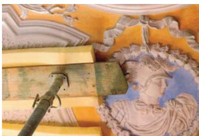
Tecto da escadaria - operações S.O. S. (protecções)
