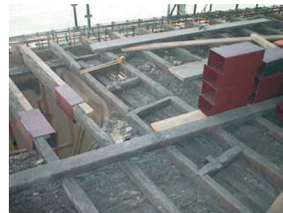
5 - Ferrolhos e tarugos de ligação parede interior/esteira
