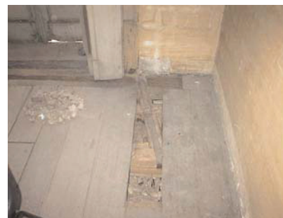
9 – Ferrolho de ligação na direcção perpendicular aos barrotes, pelo lado superior
