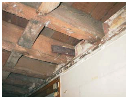
7 – Aspecto de um ferrolho de ligação piso/parede, do lado interior
