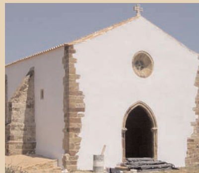
Projecto RECOPAC: Ermida de Nossa Senhora de Guadalupe, Raposeira, Vila do Bispo – antes, durante e após a intervenção
